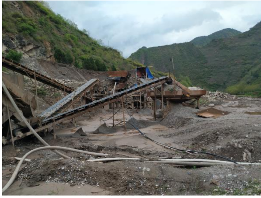
破碎工序洒水管
